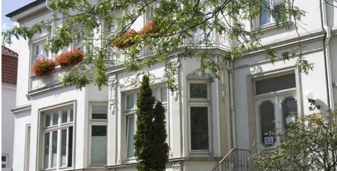
ICX-Bürogebäude in Oldenburg
